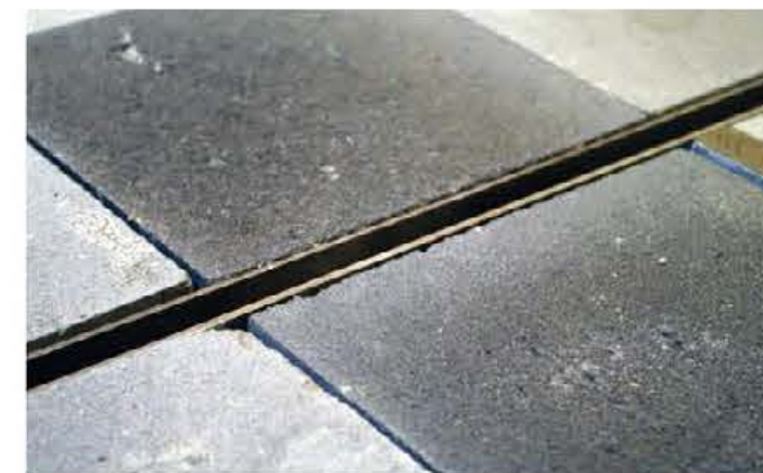
Sistema de drenagem
